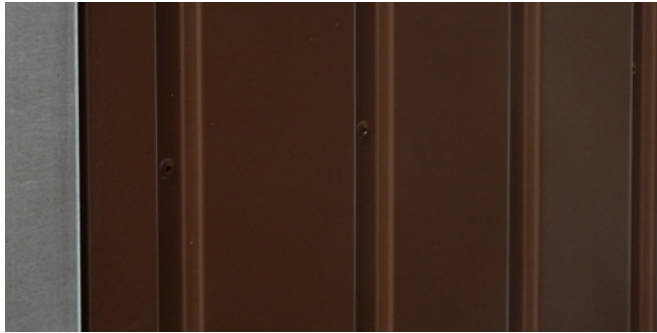
▲ Mocowanie poszycia do konstrukcji (widok od przodu)
