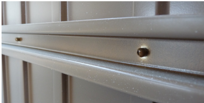
▲ Mocowanie poszycia do konstrukcji (widok od tyłu)
